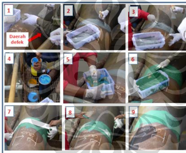
Gambar 4.20. Tahapan aplikasi pelapisan produk StrongBack yang berfungsi sebagai penguat pada pipa yang mengalami cacat
