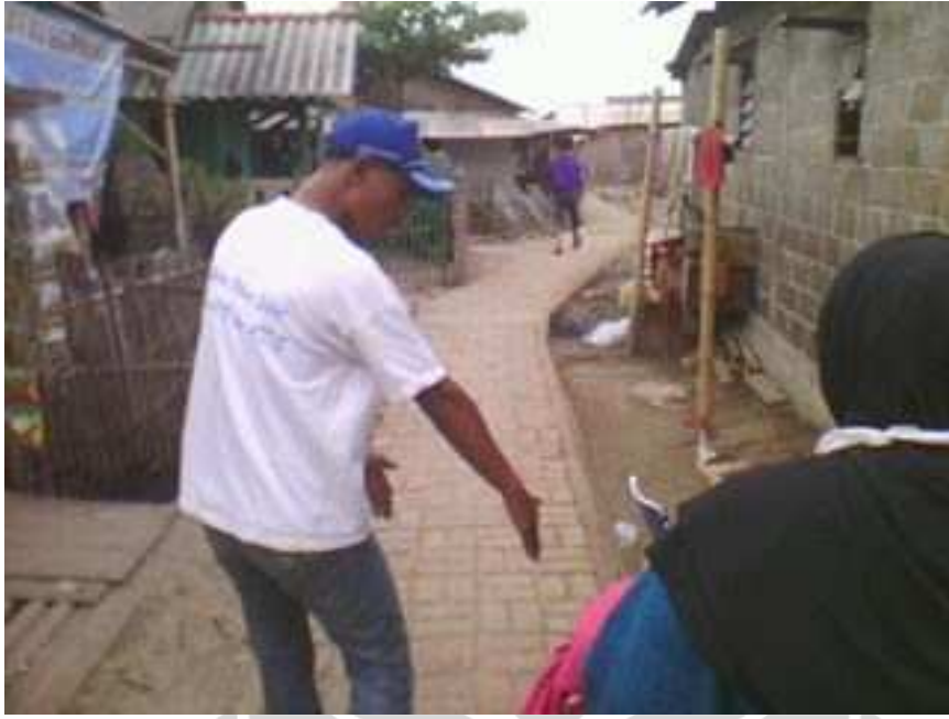
Jalan yang Telah Dipasangi Paving Block
