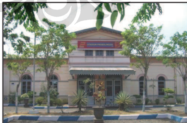
Foto 2.20 Stasiun Kereta Api Probolinggo (Oleh: Liman, 2008)
