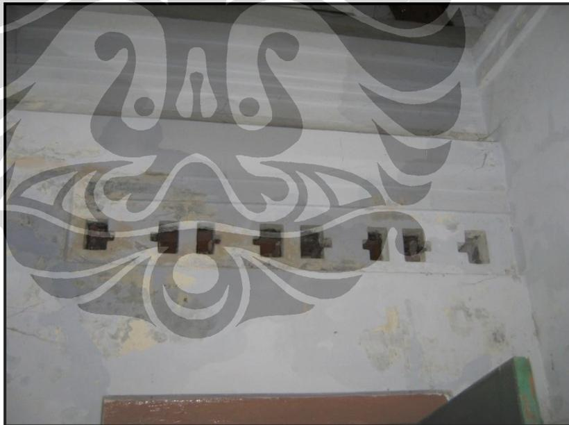
Foto 3.22. ventilasi pada bagian atas pintu selatan
