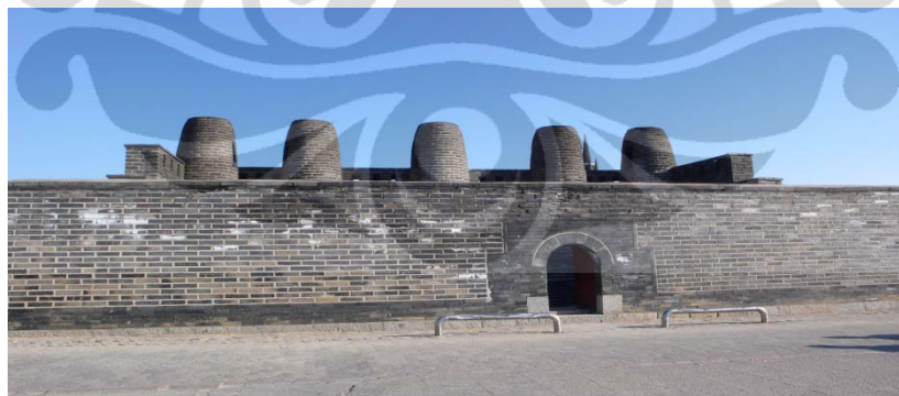
Gambar 5.7 Menara Api Bongdon
