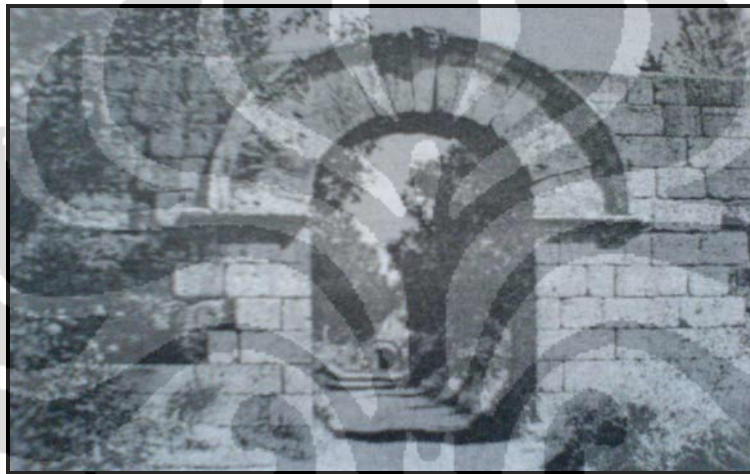
Gambar 2.2 Gerbang Berkontruksi Pelengkung Bangunan Romawi (Sumber: Sumalyo,2003:29)
