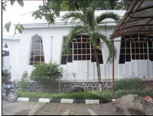
Foto 3.25 Dinding sisi barat bangunan sayap selatan (Sumber: Agustinus David, 2009)
