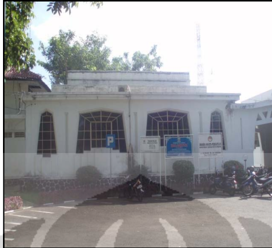
Foto 3.23 Dinding sisi timur bangunan sayap selatan (Sumber: Agustinus David, 2009)
