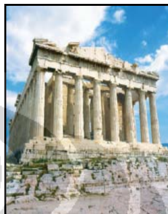
Foto 2.1 Bangunan gaya Yunani (Dok. Zambo, 2005:4)
