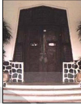
Foto 3.34 Pintu masuk bangunan utama (Sumber: Agustinus David, 2010)
