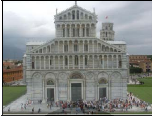
Foto 2.2 Bangunan gaya Romanes (Dok. Carolina,2005:3)
