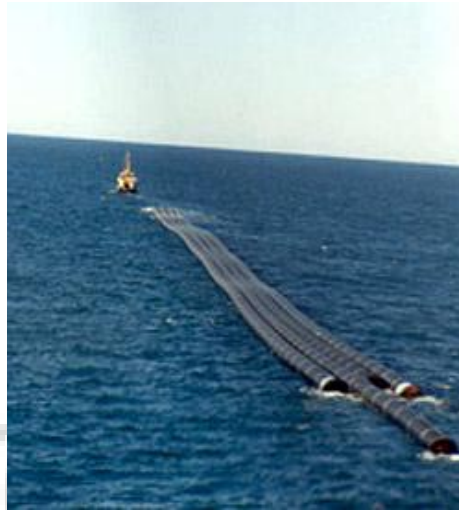
Gambar 2.10 Instalasi pipa dengan metode Tow-In ( www.pipelife.no )
