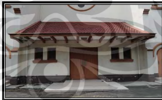
Foto 2.11 Atap Tritisan Pada Depan Bangunan
