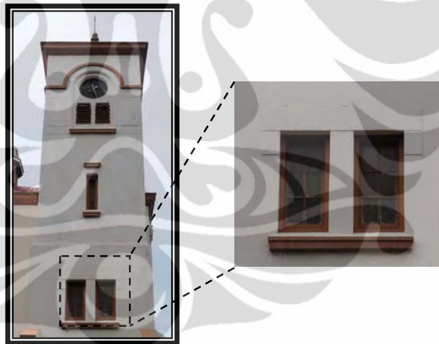
Foto 2.47 Jendela Pada Menara (Dok: Tornado G. Silitonga, 2010)
