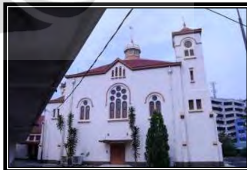
Foto 2.6 Tampak Sisi Kanan Bangunan (Dok: Tornado G. Silitonga, 2010)
