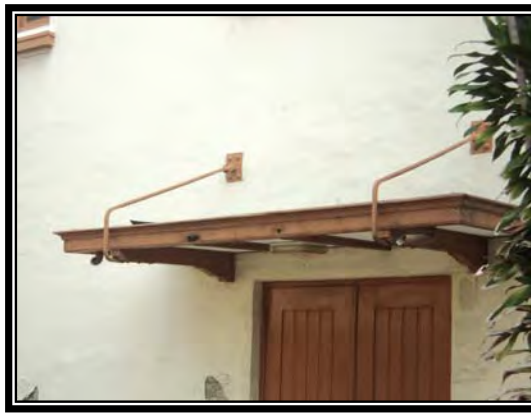
Foto 2.12 Atap Tritisan pada Sisi Samping Bangunan (Dok: Tornado G. Silitonga, 2010)
