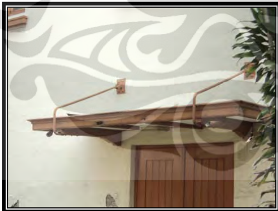
Foto 3.8 Atap Tritisan pada Dinding Samping Gereja Pniel (Dok: Tornado G. Silitonga, 2010)
