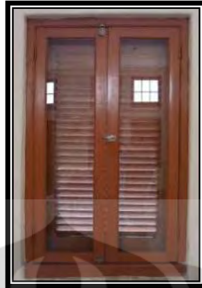
Foto 2. 41 Jendela Ruang Konsistori (Dok: Tornado G. Silitonga, 2010)
