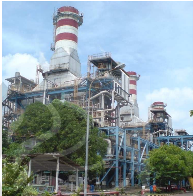
Foto 2. Cerobong PLTGU 1.1, 1.2 dan 1.3 (dari kiri ke kanan)
