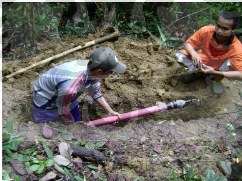
Gambar 4.10 Penguburan sensor magnetik MT
