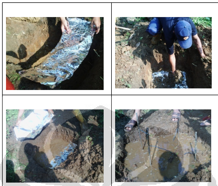
Gambar 3.11 Prosedur Pemasangan Elektroda
