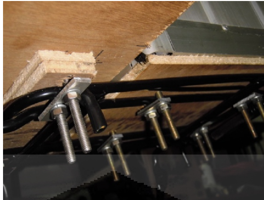
Gambar 3.7. Tiap titik di cover oleh 2 Baut ring 10mm panjang 15cm. Dilengkapi dengan ring per.
