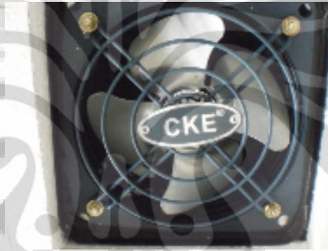
Gambar 3.17 Exhaust fan CKE APK 15-3
