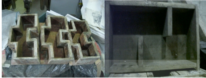
Gambar 4. 14 Bekisiting Benda Uji Geser Kubus dan Benda Uji Double-L
