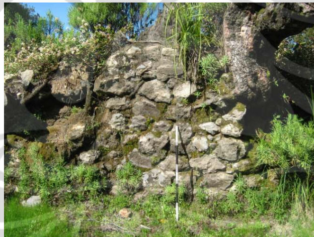
Foto 3.15 Fitur 3 (Bangunan C) sisi timur
