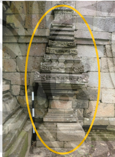
Foto 28. Menara sudut pipi tangga Candi Kedaton sisi timur (Sumber: koleksi Fajri D.N. 2010)
