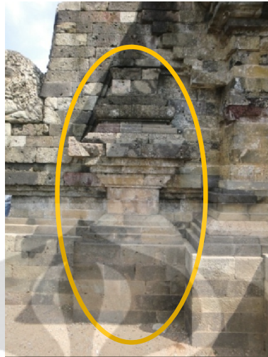
Foto 21. Menara sudut pipi tangga Candi Jawi sisi selatan (Sumber: koleksi Fajri D.N. 2010)
