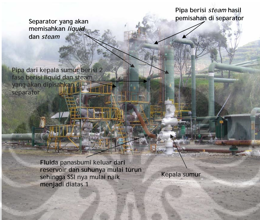
Gambar 1.4 Sumur produksi panasbumi PLTP Dieng; foto penulis
