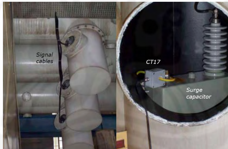
Gambar 3.3 Instalasi CT17 pada generator GT 1.2
