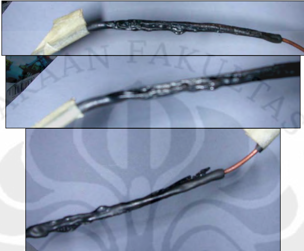
Gambar 4.5. Kondisi kabel setelah pengujian
