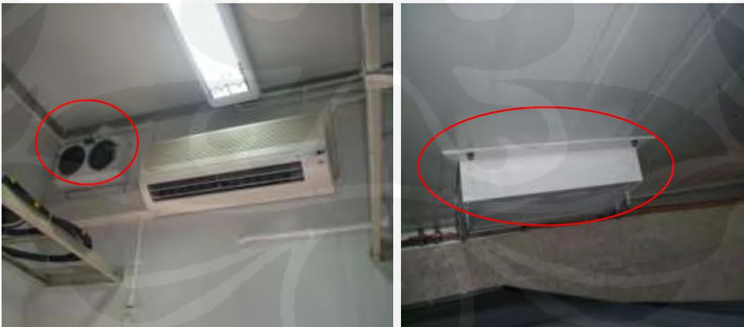
**Gambar 2.21** Letak kipas ventilasi di ruang BTS
