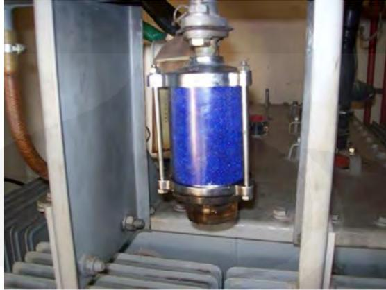
Gambar 2.13 Silicagel pada Trafo yang berisi Kristal
