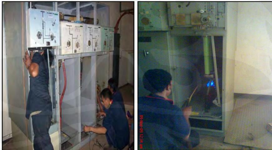
Gambar 3.6 Proses Pembersihan Corona dalam Cubicle
