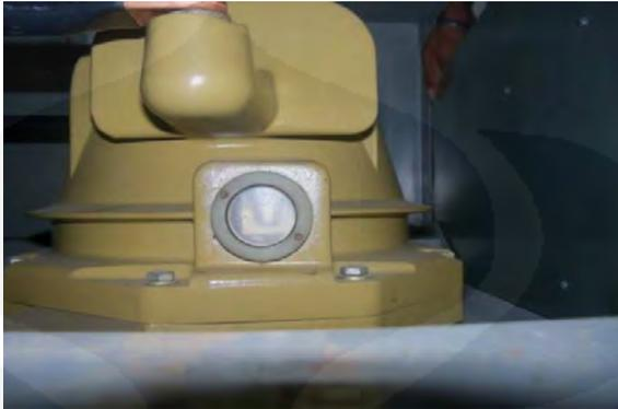
Gambar 3.5 Indikator Gas SF6 pada Cubicle TM
