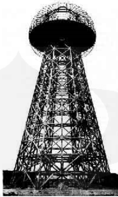
Gambar 1.2. Menara yang di gunakan Tesla untuk mentranmit tegangan sejauh 26 mil [8]
