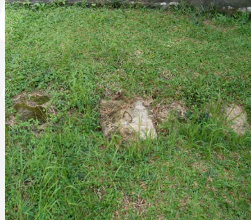
Gambar 3.5 Bak kontrol penyalur petir 1
