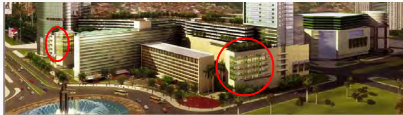
Gambar 45. 4. Massa Bangunan Grand Indonesia
