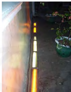
Gambar 5.24 Lampu LED Line pada Fasade Bangunan. Sumber: Dokumen Pribadi
