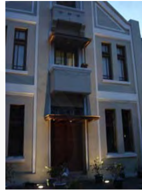
b. Bangunan bagian kanan.
