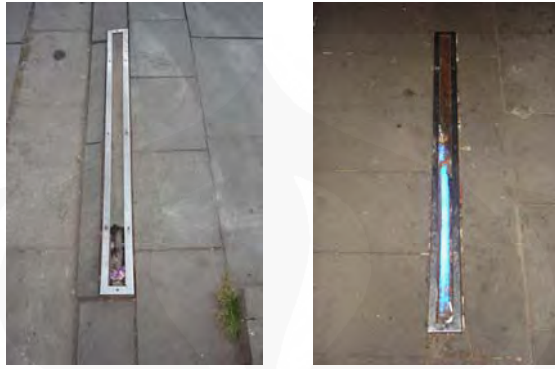
Gambar 5.18 Proteksi Terhadap Lampu LED Batten. Sumber: Dokumen Pribadi.
