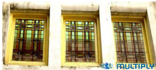
Gambar3. 13 Kaca Pada Pintu Utama Masjid Cut Meutia
