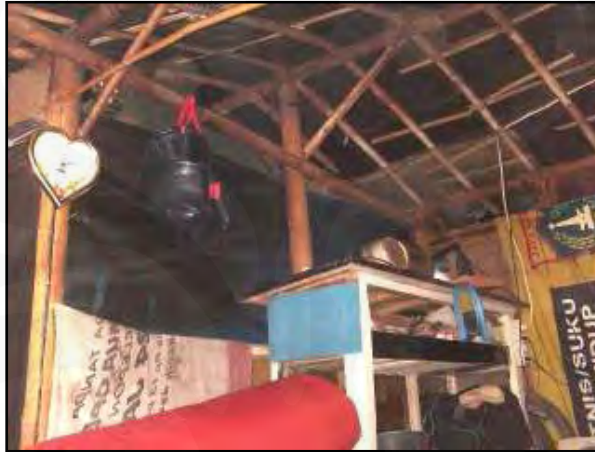
Gambar 3.11 Rangka Bangunan yang Terbuat dari Bambu
