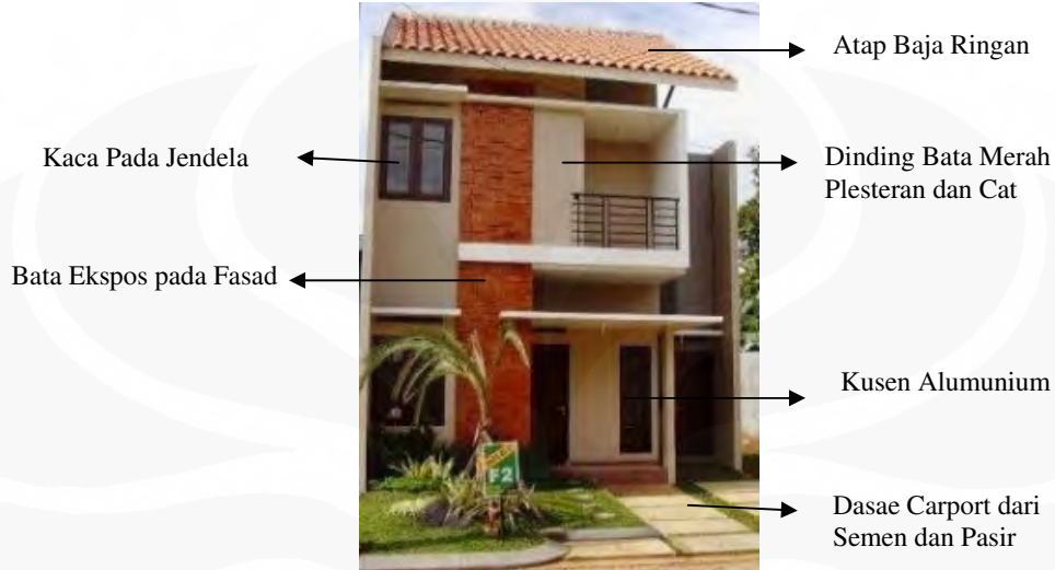
Gambar 3.40. Penggunaan Material pada Bangunan (sumber: PT. Relife Realty Indonesia)
