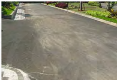
Gambar 3.8. Jalan dengan Material Aspal (sumber: dokumentasi pribadi)
