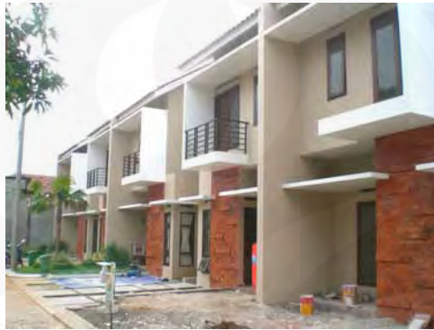
Gambar 3.30. Image Barisan Unit Townhouse Tipe 68 (sumber: dokumentasi pribadi)
