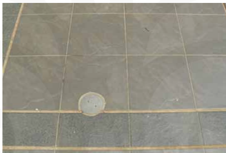
Gambar 3.18. Lubang Penyedotan Septic Tank pada Carport (sumber: dokumentasi pribadi)
