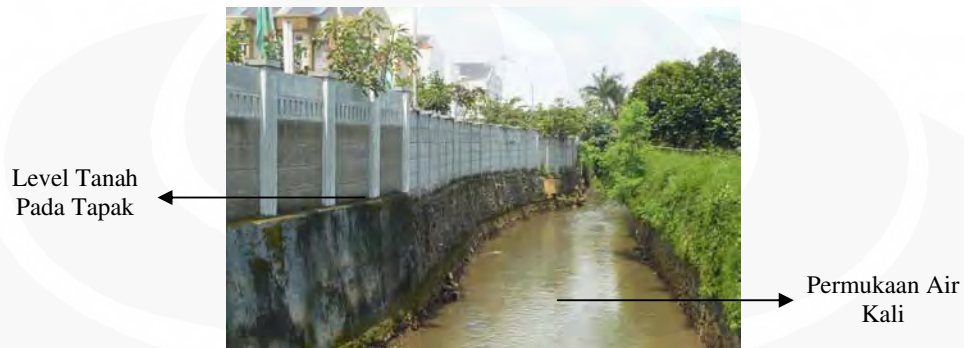
Gambar 3.3. Perbedaan Level Permukaan Air Kali dengan Level Tanah pada Tapak (sumber: dokumentasi pribadi)
