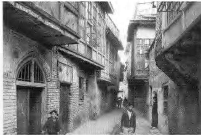
Gambar 2. 11. Jalan di Perumahan Baghdad.
