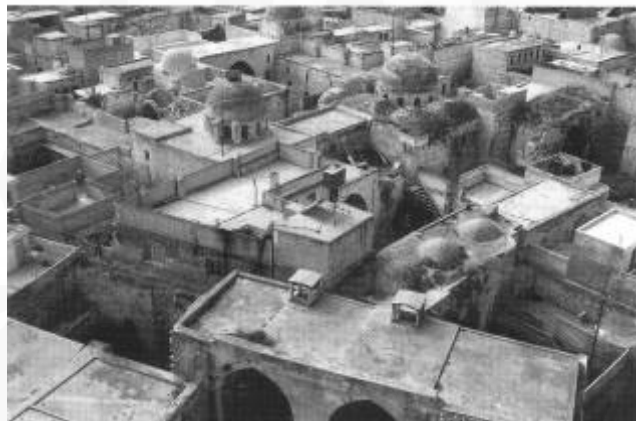
Gambar 2. 13. Foto Perumahan di Aleppo, menunjukkan kesamaan pada dinding rumah sehingga tidak menghalangi aliran udara ke tetangga.
