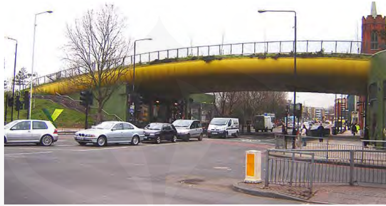
Gbr 4.7 Mile End Park Ruang bawah jembatan sebagai retail (Sumber: www.d4b.org.uk diakses 20 Juni 2009)
