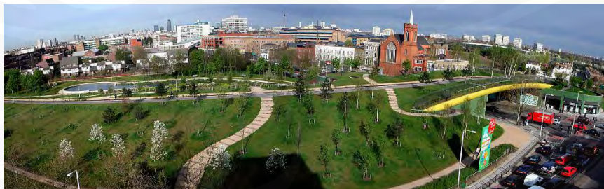
Gbr 4.6 Mile End Park Taman Kota Sebagai Jembatan Penghubung (Sumber: www.d4b.org.uk diakses 20 Juni 2009)
