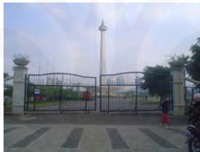
Gambar 4.23. Pintu masuk Monas Sumber:dokumen pribadi
