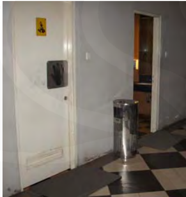
Gambar 5.23. Toilet di Citos
