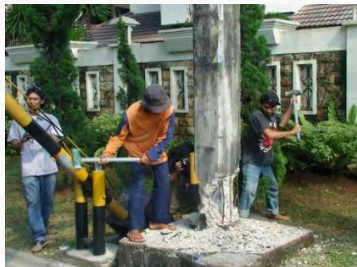
Gambar 2.5 Pembongkaran Portal
