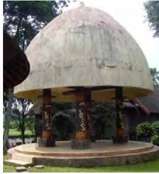
Gambar 4.12. Bangunan Lopo (Kapele) Sumber: dokumentasi pribadi. Lokasi: TMII
