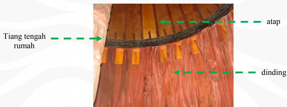
Gambar 4.11. Dinding dari Kayu. Sumber: dokumentasi pribadi. Lokasi: TMII
