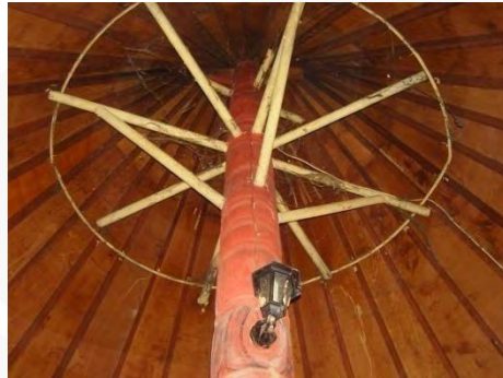
Gambar 4.8. Bentuk Rangka Atap. Sumber: dokumentasi pribadi. Lokasi: TMII
