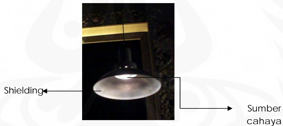
Gambar 4. 9 Pendant Lighting Halogen 50 Watt dengan Shielding
