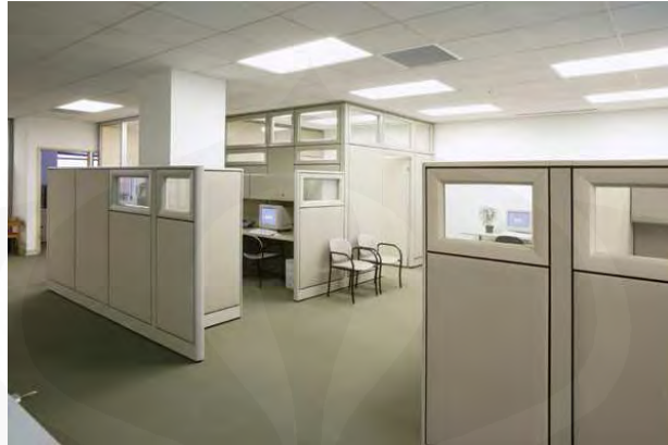
Gambar 3. 14 General Lighting pada Kantor
