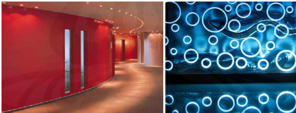
Gambar 3. 18 Penggunaan ceiling-recessed downlight untuk menciptakan pola menarik pada lantai
