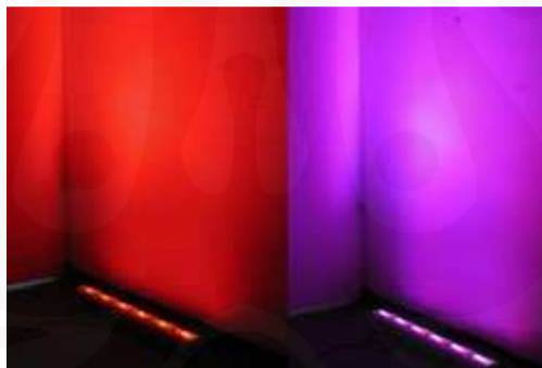
Gambar 3. 21 Wallwasher dengan Intensitas Cahaya Seragam di Tiap Titik Lampu
