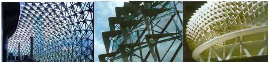
Gambar 4.20. Cladding pada Esplanade
