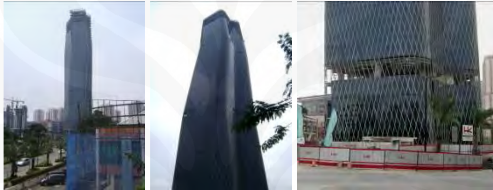
Gambar 4.9. Bakrie Tower (masih dalam proses penyelesaian) Sumber gambar: dokumentasi pribadi, diambil tanggal 19 April 2009.
