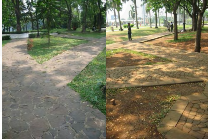
Gambar 2.5 Perbedaan Pavement yang Mengganggu Kontinuitas Path
