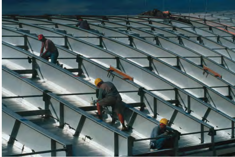
Gambar 2.3.3.20 Pemasangan Profil Baja 'I' Untuk Atap Zentrum Paul Klee
