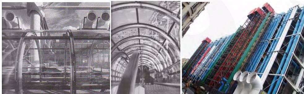
Gambar 2.3.3.28 Ruang Eskalator (Kiri dan Tengah), Pipa Utilitas Bangunan (Kanan)
