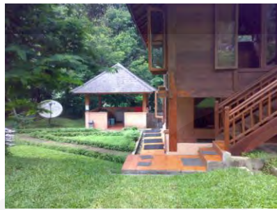
Gambar 3. 47 Ruang Laundry yang bersebelahan dengan musholla dan dibagian bawahnya terdapat ruang isolasi dan ruang medis Sumber: dok.pribadi
