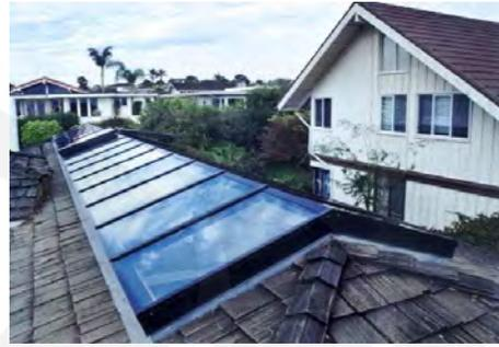
**Gambar 2.18.** Contoh *ridge skylight* pada bangunan.<sup>(20)</sup>
