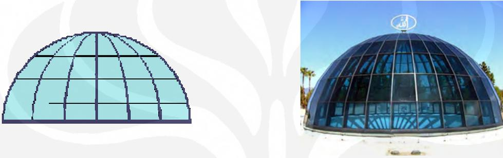
**Gambar 2.16.** Contoh *dome skylight* pada bangunan.<sup>(18)</sup>
