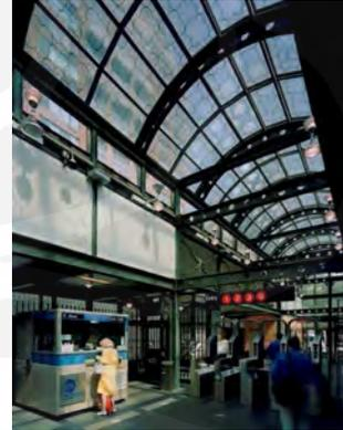
**Gambar 2.20.** Contoh *barrel vault skylight* pada bangunan.<sup>(22)</sup>
