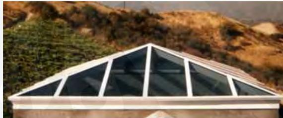
**Gambar 2.14.** Contoh *pyramid skylight* pada bangunan.<sup>(16)</sup>
