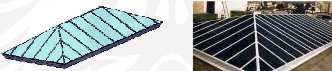
**Gambar 2.17.** Contoh *hip ridge skylight* pada bangunan.<sup>(19)</sup>
