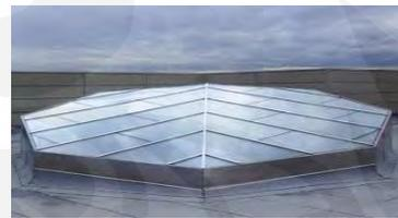
Gambar 2.12. Contoh *flat skylight* pada bangunan.<sup>(14)</sup>
