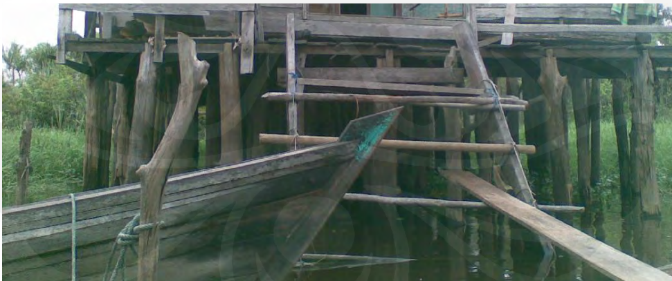
Gbr 16. Foto tiang pancang (penyangga bangunan) Sumber : Dokumentasi hasil survey,2010
