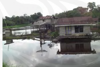
Gbr 13d. Tipe rumah rakit(tidak panggung) dengan atap bubungan sederhana dan tidak berserambi
