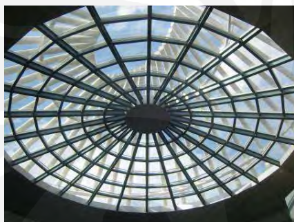
Gambar 3.71 Skylight pada bagian atrium (Sumber: Dokumentasi pribadi)
