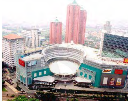
Gambar 3.21. Bagian depan Plaza Semanggi (Sumber: http://static.panoramio.com )
