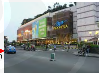
Gambar 3.5 Fasad Plaza Indonesia yang menghadap Jl. Kebon Kacang
