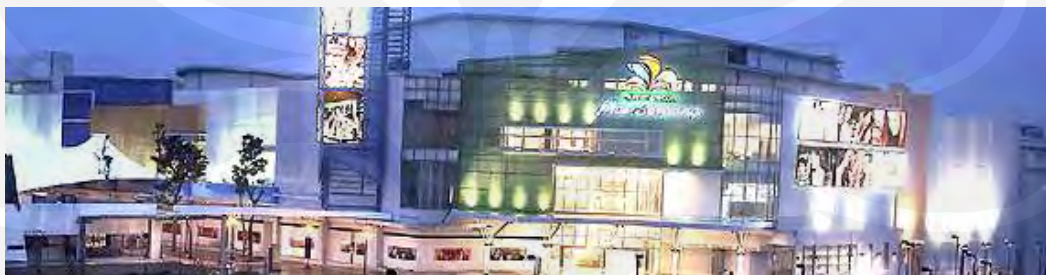
Gambar 5.1 tampak luar SMS
