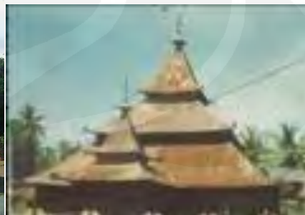
Gambar 4.13 Gambar Mesjid Jami' Sebelum renovasi Sumber : Dokumentasi Pribadi
