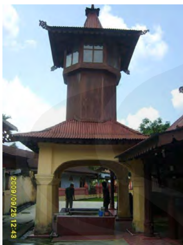
Gambar 4.18 Menara Mesjid Sumber : Dokumentasi Pribadi
