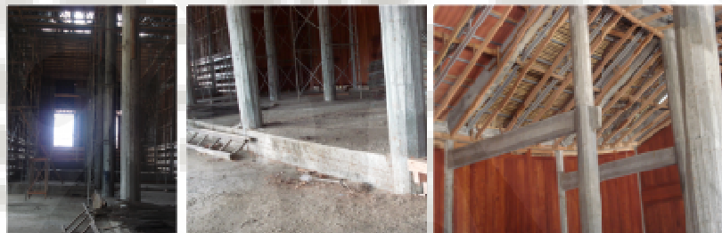
Gambar 5.59 Struktur beton yang diterapkan pada bangunan
