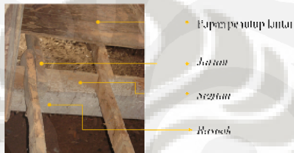
Gambar 5.30 Struktur lantai
