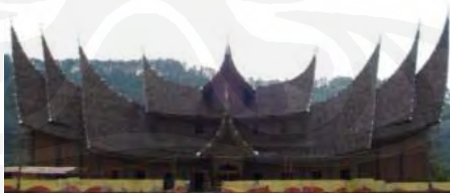
Gambar 5.58 Istano Basa Pagaruyuang (dalam proses pembangunan)
