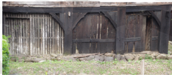
Gambar 5.19 Kolong rumah ditutupi dengan kisi-kisi
