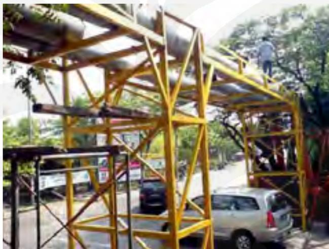
Gambar 4.27 Pipa Pompa Banjir Melintas Di Atas Sebuah Jalan
