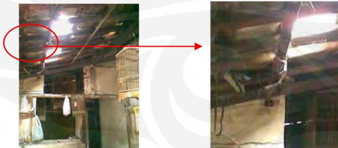
**Gambar 3.39.** Bagian atap yang bocor ditutup dengan kertas
