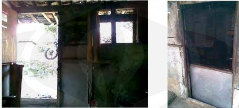
**Gambar 3.31. Kiri** : Buka pintu memberikan penghawaan alami **Kanan** : kondisi pintu dibuka setengah dilihat dari luar untuk tetap memberi penghawaan alami di dalam rumah
