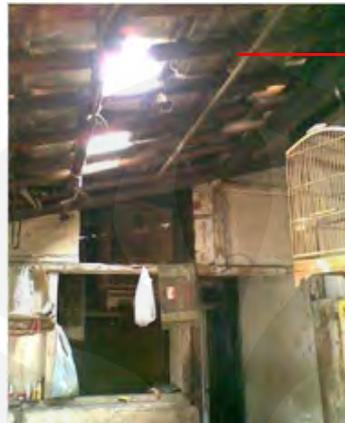
Atap dengan rangka bambu
