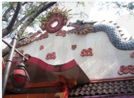
Gambar 3.58. Ornamentasi Naga yang Mengigit Mutiara. Sumber : Dokumentasi pribadi
