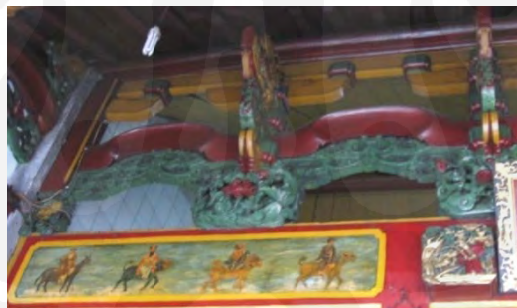
Gambar 3.25. Area Ventilasi Udara Sumber : dokumentasi pribadi
