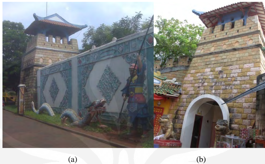
Gambar 3.63. (a) Tampak Luar Tower, (b) Tampak Dalam Tower Sumber : Dokumentasi pribadi
