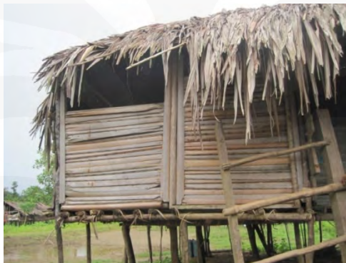
Gambar 3.18 Penggunaan gaba-gaba sebagai material dinding rumah (Sumber: dokumentasi pribadi)
