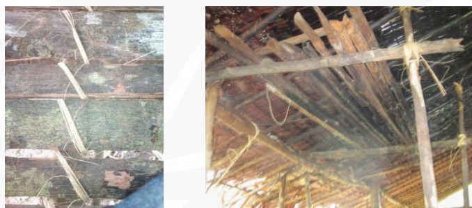
Gambar 3.19 Sambungan ikat dengan tali rotan pada struktur dan dinding rumah (Sumber: dokumentasi pribadi)
