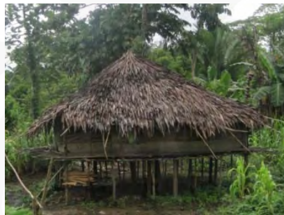
Gambar 3.7 Rumah tradisional A (Sumber: dokumentasi pribadi)
