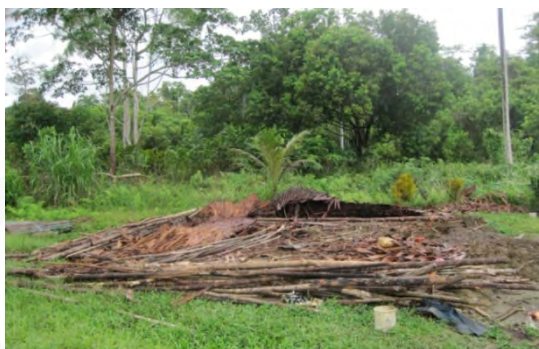
Gambar 3.20 Material bangunan yang dibongkar karena sudah tidak layak dihuni (Sumber: dokumentasi pribadi)
