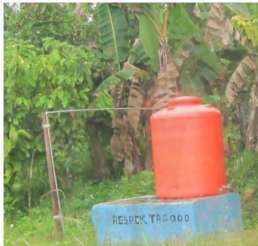
Gambar 3.4 Sumur bor di Kampung Usku 2 (Sumber: dokumentasi pribadi)
